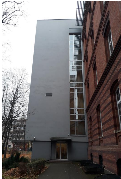
Widok zewnętrzny bocznej klatki schodowej
