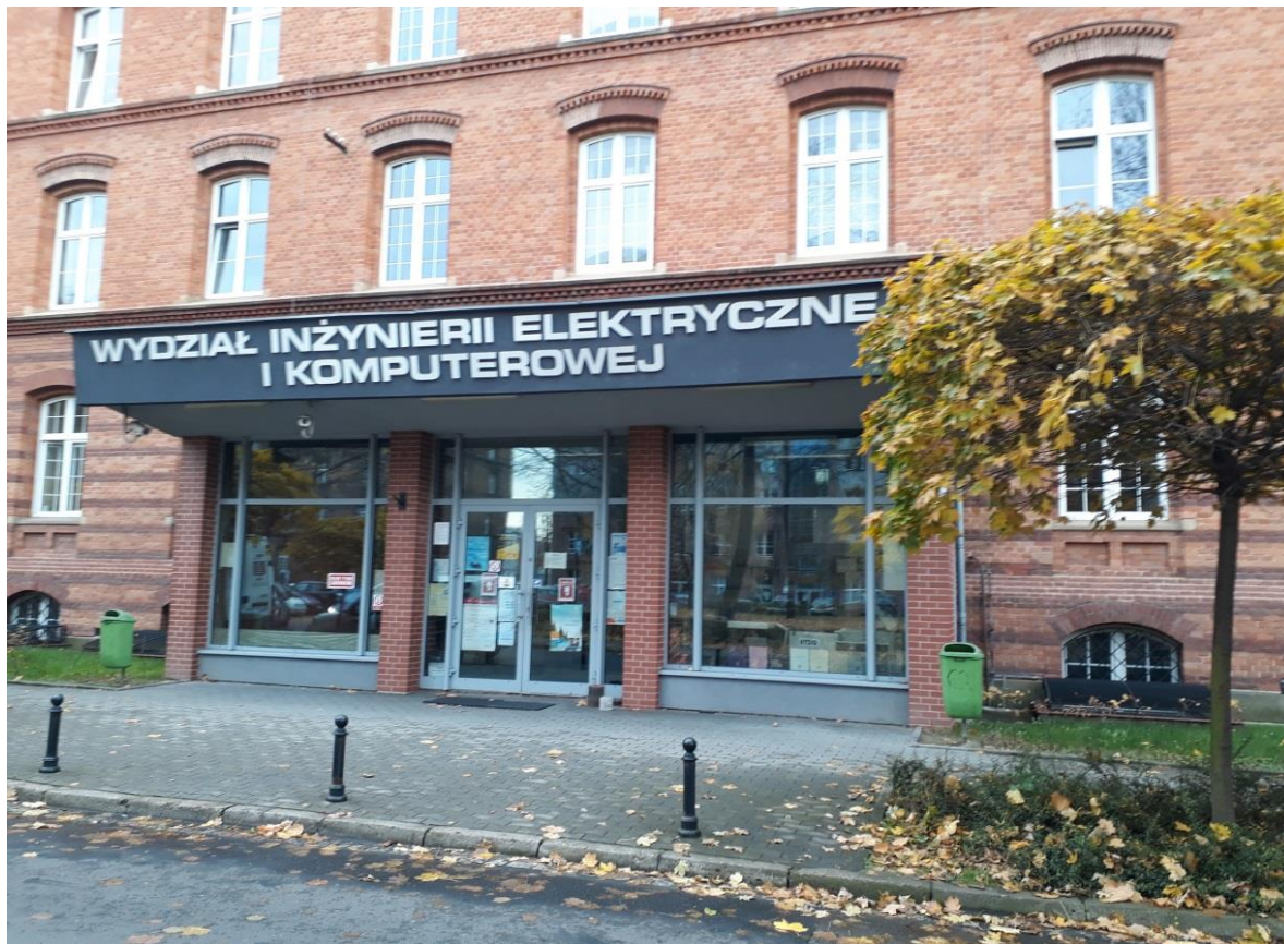
Wejście główne do budynku
