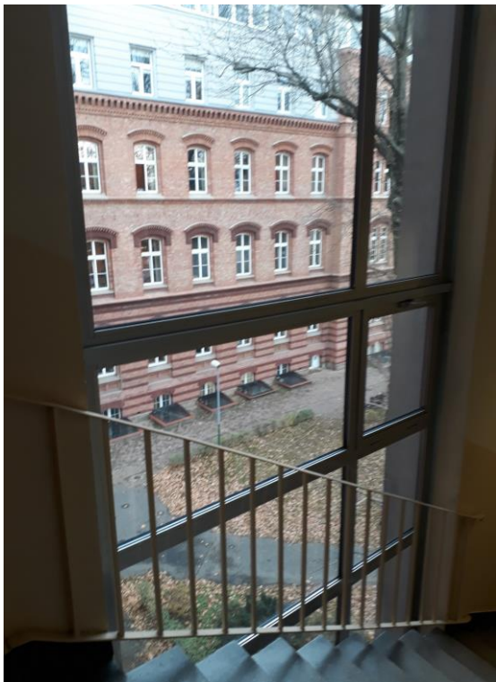
Widok wewnętrzny bocznej klatki schodowej
