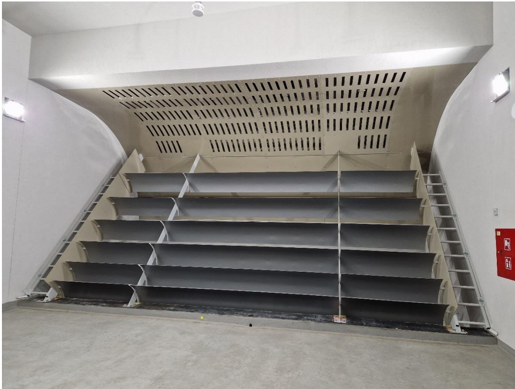
Tunel TA.2.G Elementy wyposażenia specjalistycznego – kierownice i zaokrąglenia naroży
