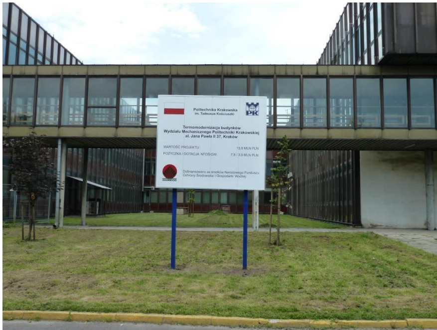
Budynek WM przed termomodernizacją (fragment)
