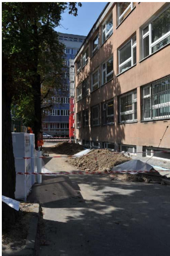
Budynek WIL w trakcie termomodernizacji (fragment)
