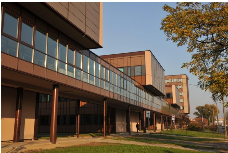
Widok na budynki WM (6a, 6b, 6c) po termomodernizacji
