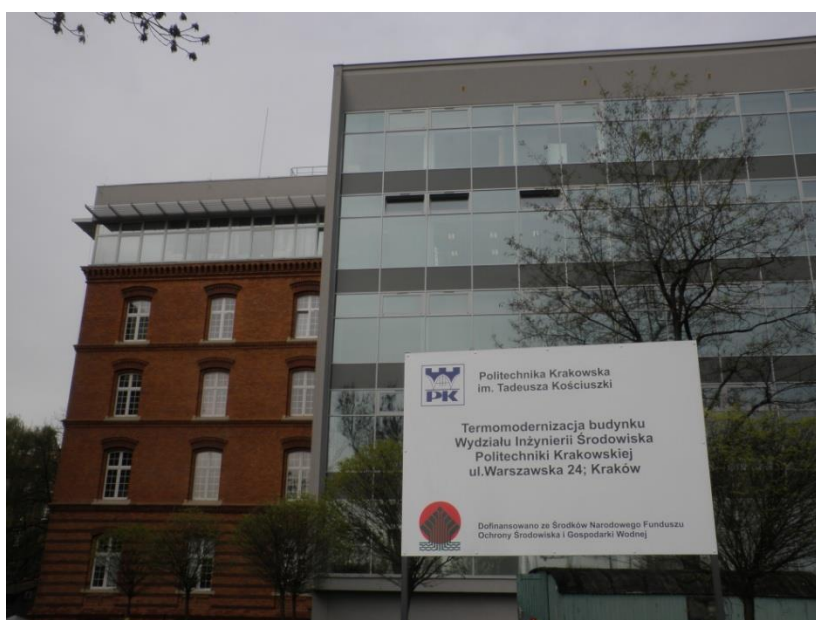
Budynek WIŚ po termomodernizacji
