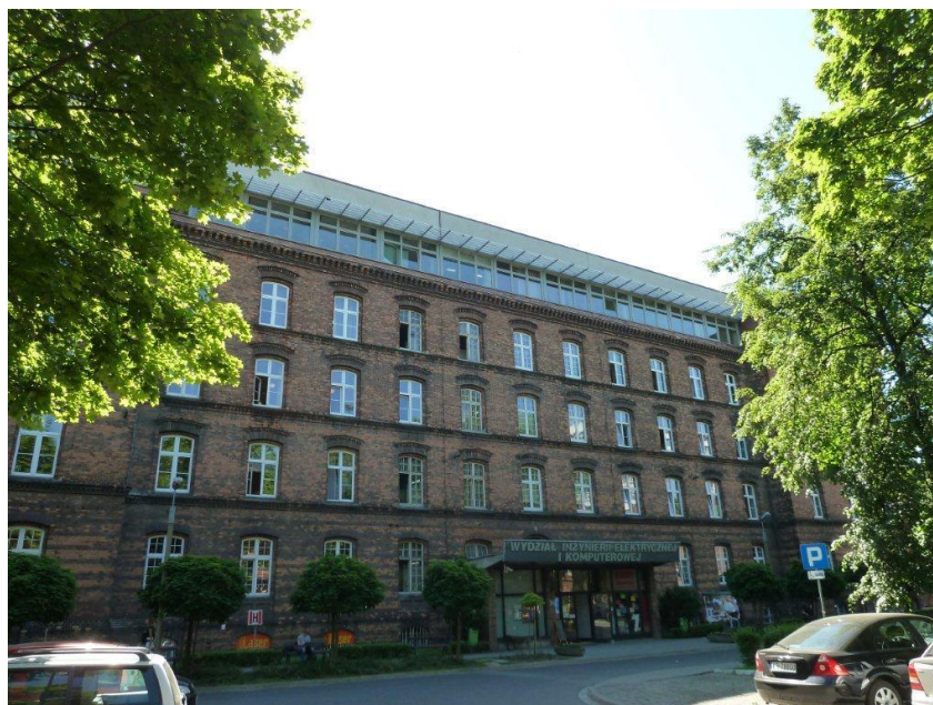
Budynek WIEiK przed termomodernizacją
